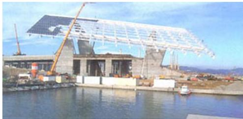
**Fig. 20. Vista de pérgola con placas fotovoltaicas en proceso de instalación, en área Forum, Frente Litoral Bèsos, Barcelona, diciembre de 2003.** Foto: I. del Levant de Barcelona SA., op. cit.
